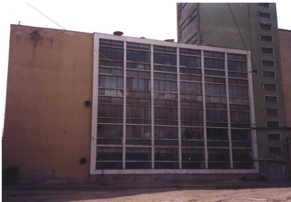
Figura 5.1b. Hala de fierbere - fațada principală.
