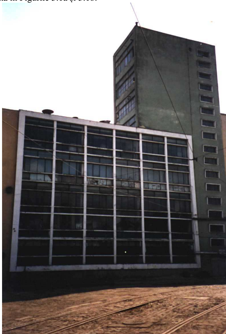
Figura 5.1a. Hala de fierbere - fațada principală.
